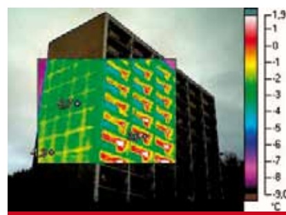
Teplo unikajúce medzi stenovými panelmi.
