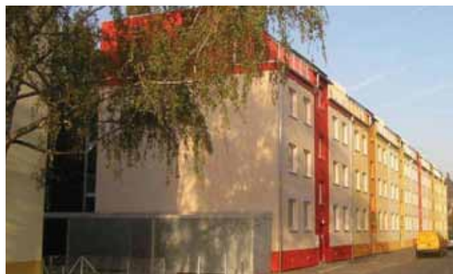
Obr 3: Po renovácii na pasívny štandard – Projekt Tevesstrasse vo Frankfurte (Nemecko). Ročná spotreba energie na vykurovanie 17 kWh (m 2 a) podľa výpočtu PHPP a spotreba primárnej energie (na kúrenie, prípravu (ohrievanie) teplej vody a pomocnú energiu) podľa vyhlášky EnEV37 kWh/(m 2 a) (Zdroj Passivhaus Institut)
