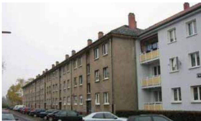
Obr 2: Pred renováciou – Projekt Tevesstrasse vo Frankfurte (Nemecko). Ročná spotreba energie na vykurovanie 290 kWh (m 2 a) podľa výpočtu PHPP a spotreba primárnej energie (na kúrenie, prípravu (ohrievanie) teplej vody a pomocnú energiu) podľa vyhlášky EnEV 270 kWh(m 2 a) pred rekonštrukciou. (zdroj Passivhaus Institut)
